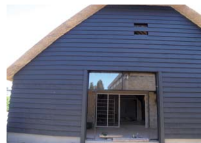
De houten planken zijn voorbehandeld met ThermoShield Nature Primer en vervolgens met twee lagen ThermoShield Nature. Voor de vochtregulering is één systeem van belang.
